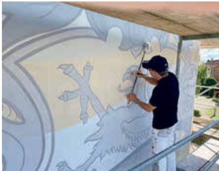
Manuel Rackow bringt Ueckermündes Stadtwappen auf der Hausfassade an.
