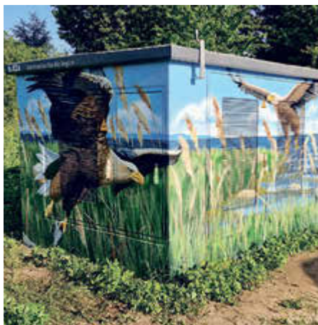
Das Traföhäuschen in Bellin
